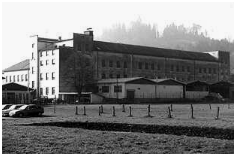
Pogled na sjeverno pročelje vojarnе bivše kraljevske jugoslavenske vojske u Slovenj Gradecu u današnjem stanju. Glavni ulaz u zgradu je zatvoren dogradnjama.
